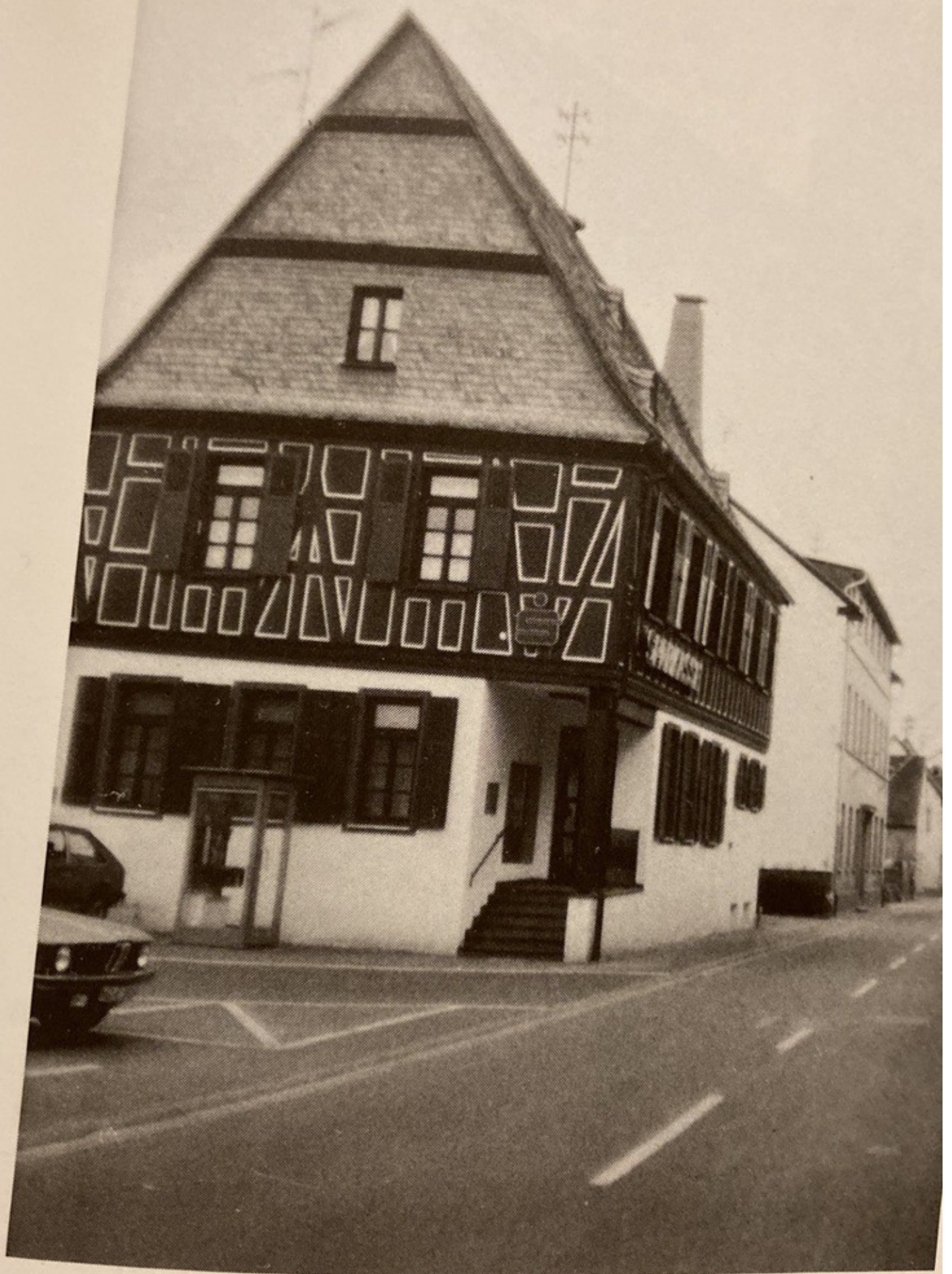
Das gleiche Anwesen, 1980 von der Kreissparkasse erworben, umgebaut und 1981 bezogen. wird als deren Filiale betrieben.
