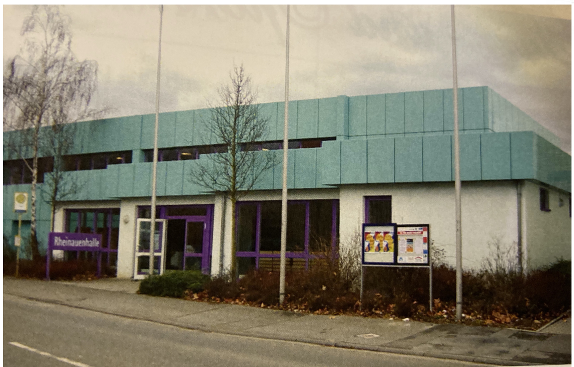
Die von der Turnhalle zur Mehrzweckhalle umgebaute Rheinauenhalle.
